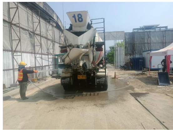
รูปที่ 12 พื้นที่ล้างทำความสะอาดล้อรถบรรทุก
