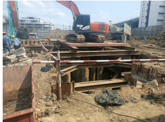
รูปที่ 8 ระบบป้องกันดินพัง (Sheet pile)
